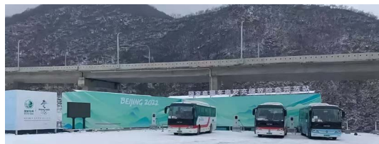
▲ 2022 北京冬奥会 10kV 发充储充电站示范工程项目
